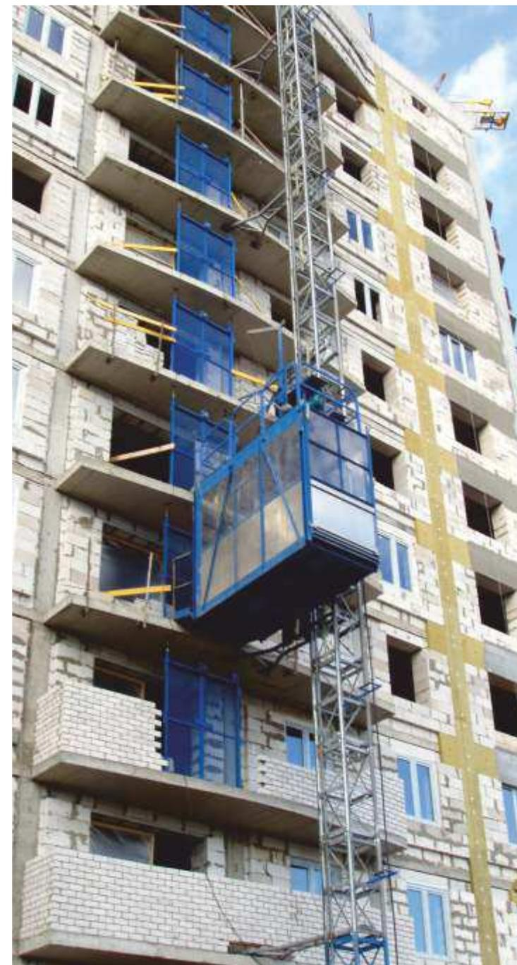
Платформа рабочая мачтовая ПРМ-2000 предназначена для размещения рабочих и материалов при выполнении различных фасадных работ при новом строительстве, реконструкции зданий, монтаже технологических стен, установки окон и т.п.
